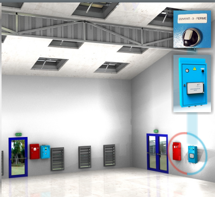
Après installation commande aération
